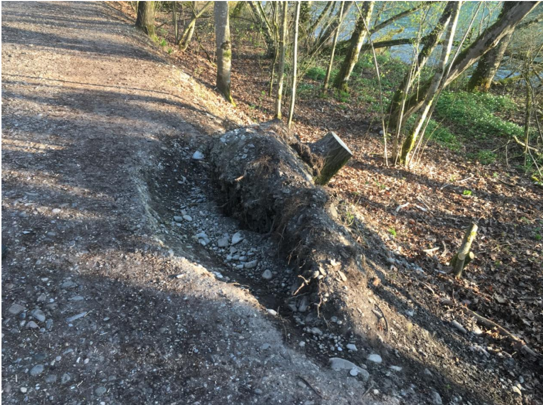
Abb. 9: Farhubel: Kleinere Schäden entlang des Hochwasserschutzdammes werden instand gestellt.
