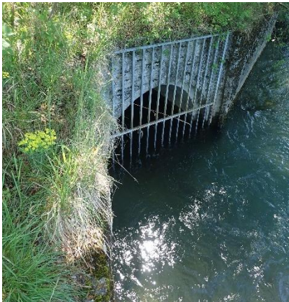
Auslauf der ARA Unteres Kiesental am rechten Ufer.
