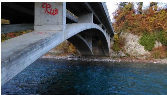
Untersicht der Jabergbrücke.
