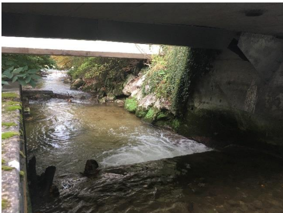
Chise Durchlass Autobahn, Blick in Fliessrichtung
