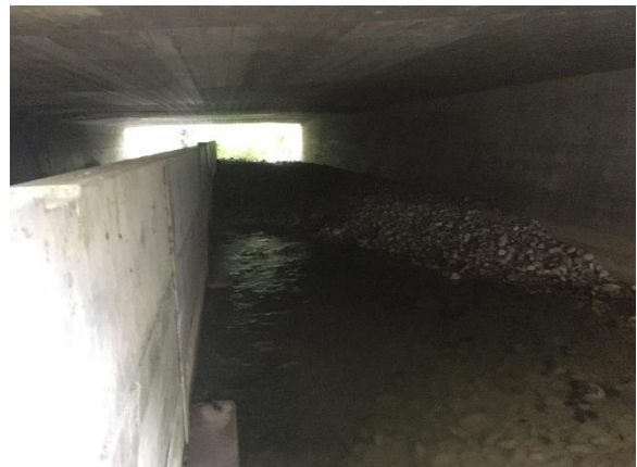
Chise Durchlass Autobahn, Blick gegen Fliessrichtung
