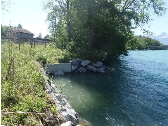
Auslaufbauwerk des WVRB am rechten Ufer
