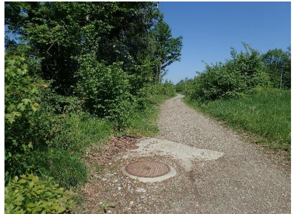
Schachtdeckel vor dem Auslaufbauwerk der ARA Unteres Kiesental.
