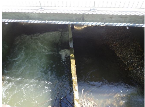
Trennmauer in der Chise bei den Durchlässen.
