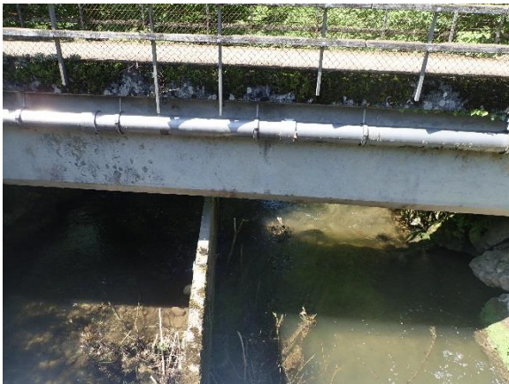
Trennmauer in der Chise bei den Durchlässen.
