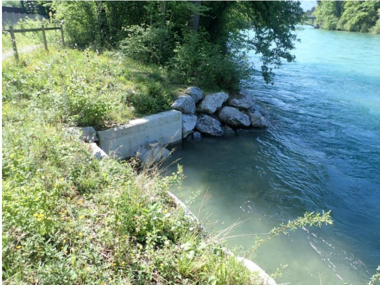
Abbildung 18: Einleitbauwerk des WVRB bei KM 9.56.
