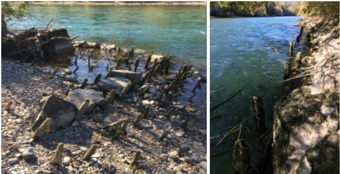
Abbildung 1: Zerstörte Uferschutzmassnahmen auf der rechten Aareseite im Projektperimeter (Quelle: OIK II, TBA Kanton Bern).
