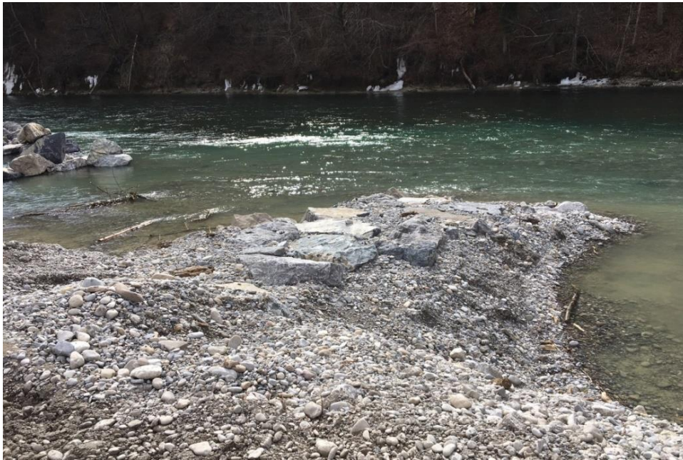
Abbildung 29: Beispiel einer überschütteten Blockbuhne (Quelle: OIK II, TBA Kt. Bern).
