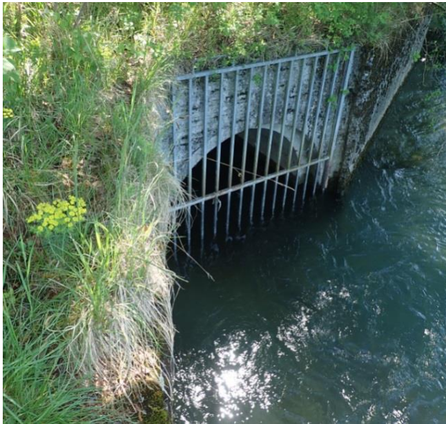
Abbildung 19: Auslaufbauwerk der ARA Unteres Kiesental.
