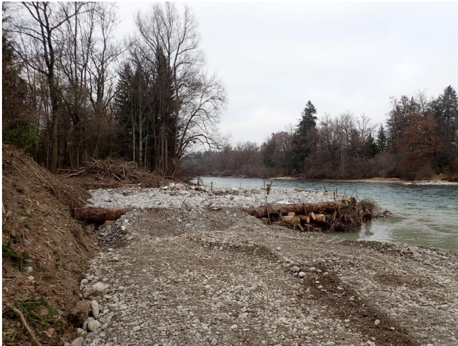
Abbildung 31: Fertiggestellte ELJ-Buhne an der Aare bei Belp Farhubel
