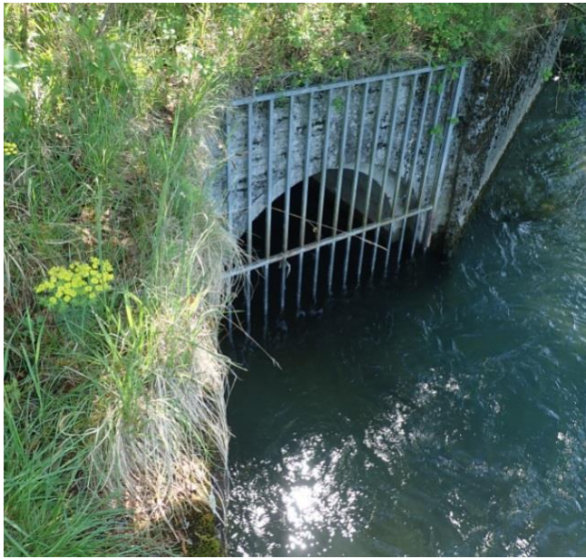
Abbildung 19: Auslaufbauwerk der ARA Unteres Kiesental.
