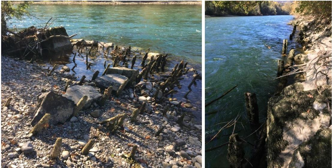
Abbildung 1: Zustand des rechtsufrigen Uferschutzes im Projektperimeter.
