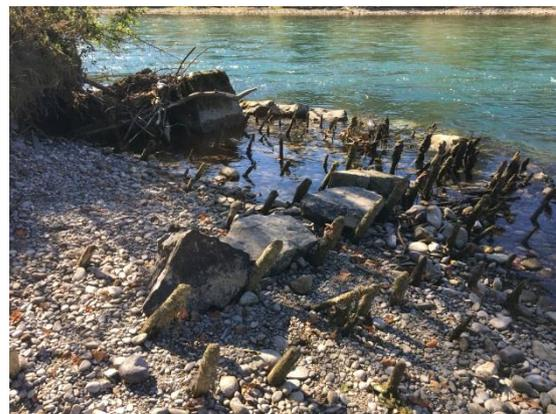
Wenn Bühnen vollständig zerstört sind, fallen aufwändige Sanierungen an.
