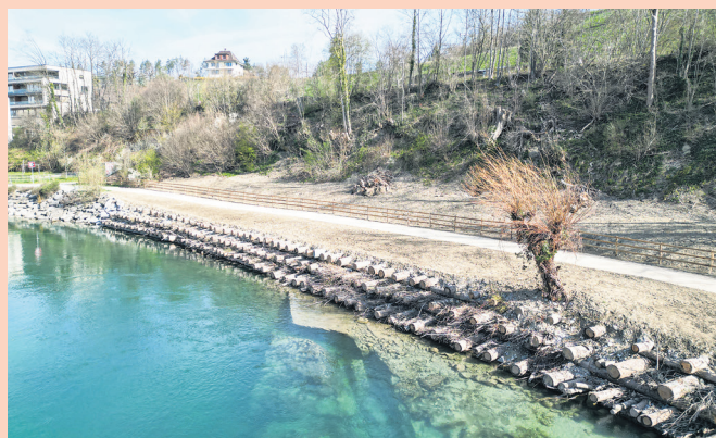
Holzverbau mit Baumstämmen in der Aarekurve.
