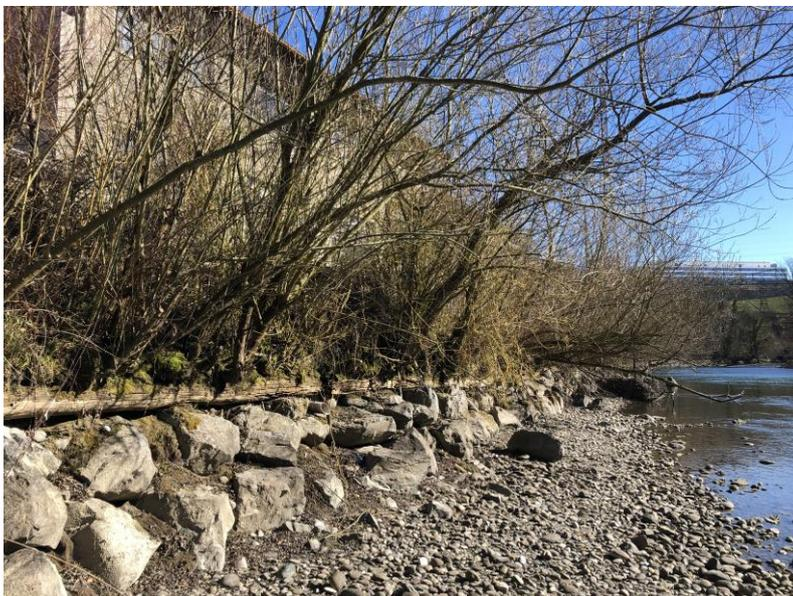
*Abbildung 6: Blockverbau im unteren Bereich der Hammerwerke*
