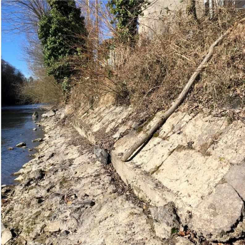
*Abbildung 5: Uferpflasterung mit belastetem Material im Bereich der Hammerwerke*
