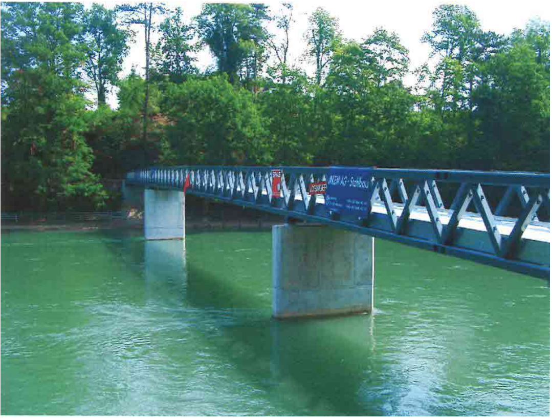
Ausführungsvariante Fachwerktrögbrücke
