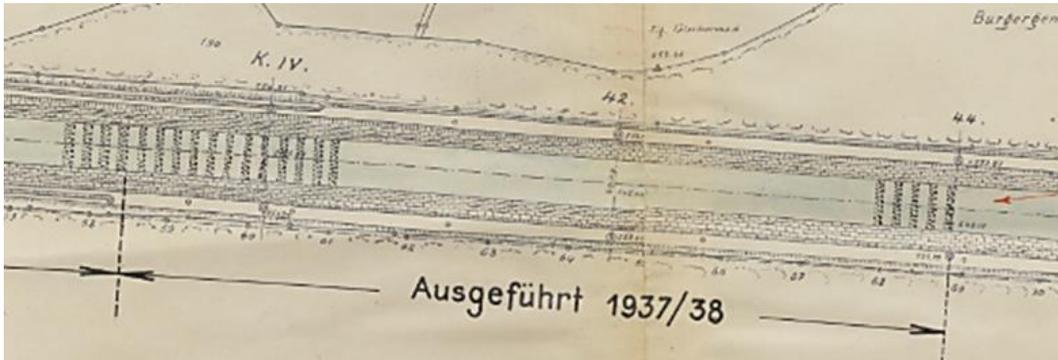
Abbildung 2.4 Planausschnitt mit dem Sohlenverbau in der Aare aus dem Jahr 1937/38
