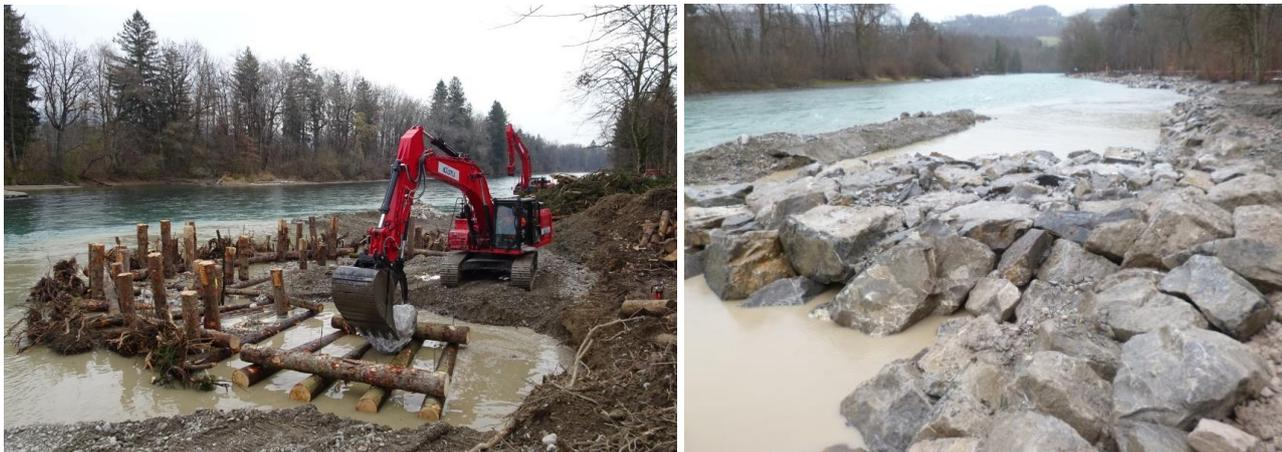
Abbildung 4.9 Engineered Log Jam (ELJ) Farhubel / Steinbühne Muri in Realisierung
