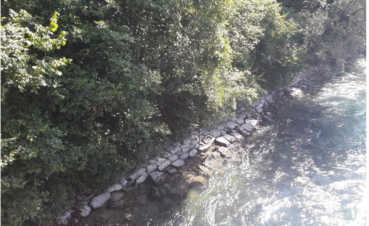
Bild 7: Beschädigter Blocksatz oberhalb der SBB-Brücke (km 6.400)
