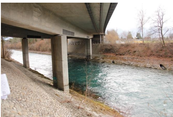
Foto 6: Aare bei Autobahnbrücke.
