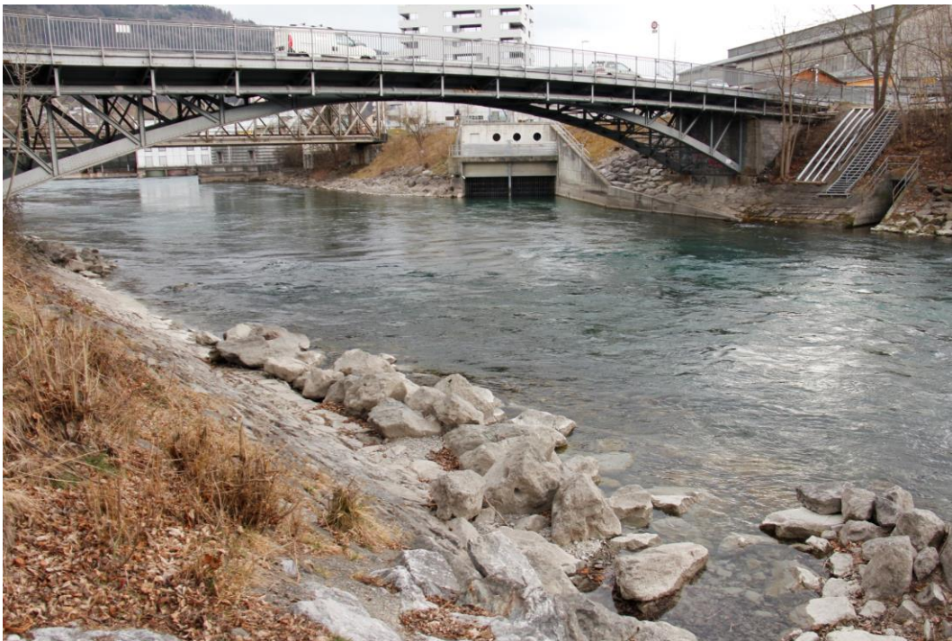
Abbildung 35: Regiebrücke Schwäbis (Blick flussaufwärts).
