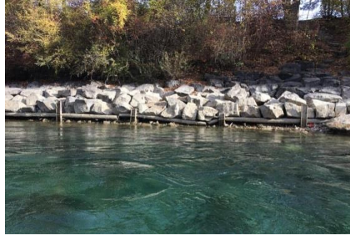
Abbildung 17: Freigelegte Längshölzer der Fundationsicherung oberhalb der Fussgänger- und Velobrücke beim Kaliforni.
