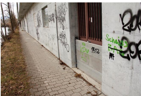
Foto 3: Gebäudeeingang mit Objektschutz (Dammbalken).
