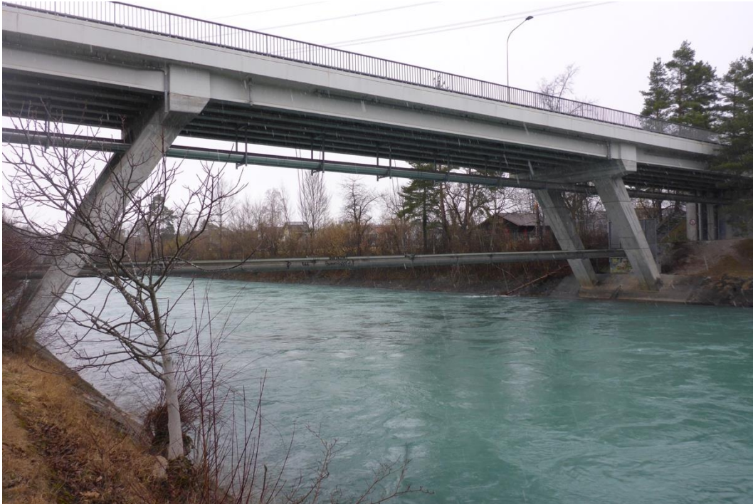
Abbildung 36: AMP Brücke mit Leitung (Blick flussabwärts).
