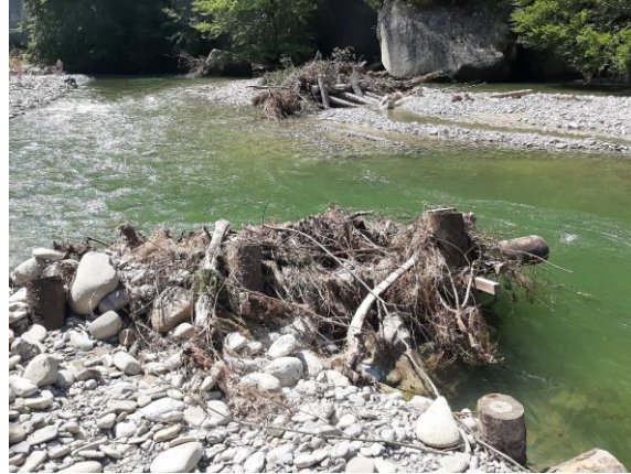
Abbildung 29: Aufbauschema eines Deflektor-ELJs und Beispielbild von zwei ELJ-Deflektoren aus der Sense.
