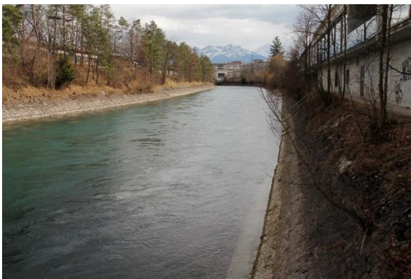
Foto 2: Aare mit gepflastertem Uferverbau im Bereich des Waffenzentrums.
