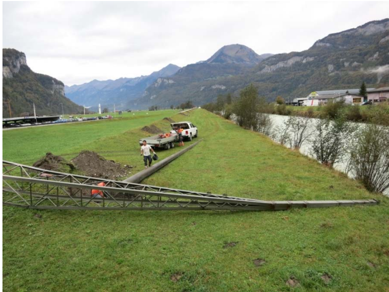
Linkes Vorland (Installationsplatz), Richtung Brienz, Abbruch BKW Freileitung
