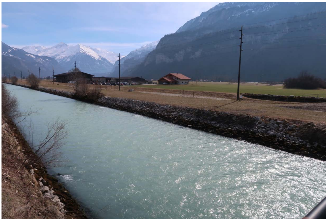
Linksufriges abgesenktes Vorland oberhalb der Hirsibrücke: Perlen vorne belassen, dahinter Kleintierstrukturen mit Steinlinsen und frisch gesäte Wiese und Heckenbepflanzung (noch Jungpflanze) mit Holzpfosten geschützt. (Vergleich Gestaltungspläne)
