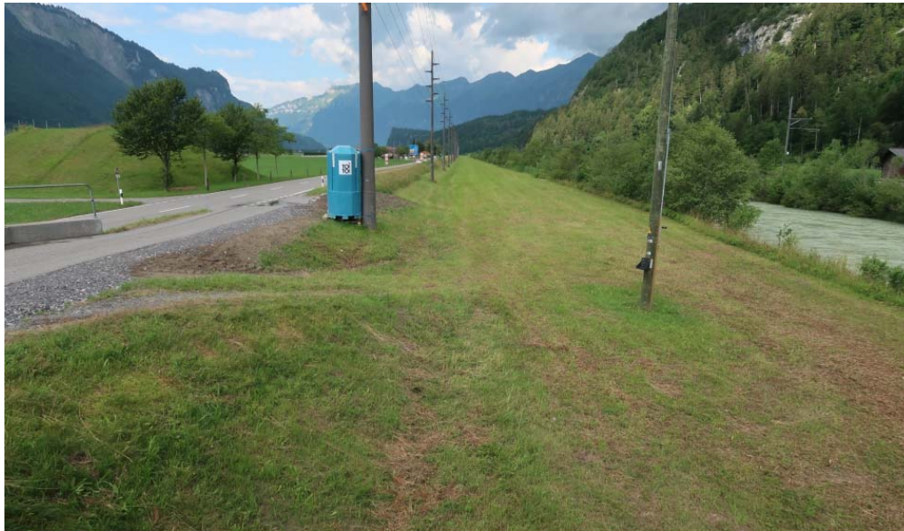
Linkes Vorland, Richtung Brienz
