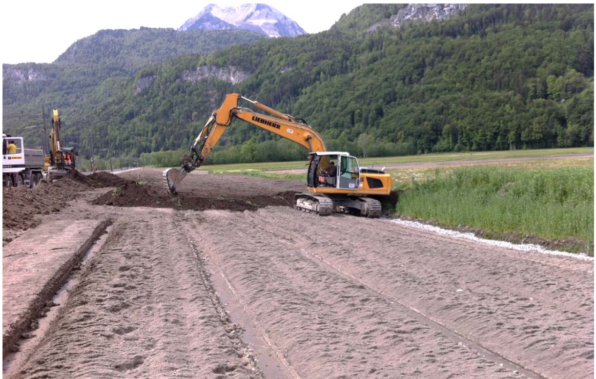
Anlegen von A-Boden auf sandiger, gelockerter Rohplanie (Aushubmaterial vom Vorland). Am Hangfuss ist der mit Rundkies verfüllte Sickergraben sichtbar. Beispiel aus dem ISP Junzlen, Meiringen.
