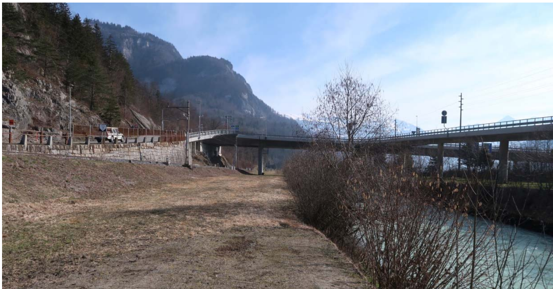
Rechtsseitiges Vorland, unterhalb Balmhofbrücke, Richtung Meiringen, unterster Projektabschnitt über 500m'
