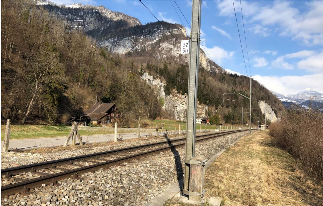
Rechtsseitiges Vorland, Richtung Meiringen 300m' schmaler Bereich ohne Vorlandabsenkung.
